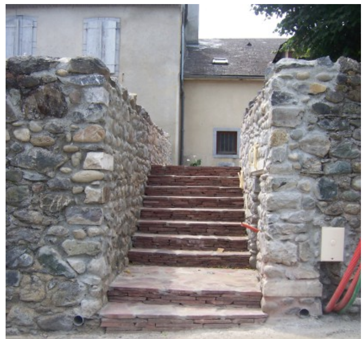
▲ Photo 13 L'escalier terminé
